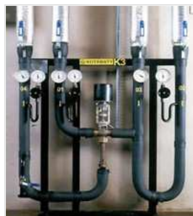
Obr. 4 Reálný ejektorový blok
