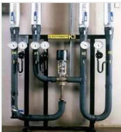
obr. č. 8 - Reálný ejektorový blok bez regulátoru tlakové difference.
